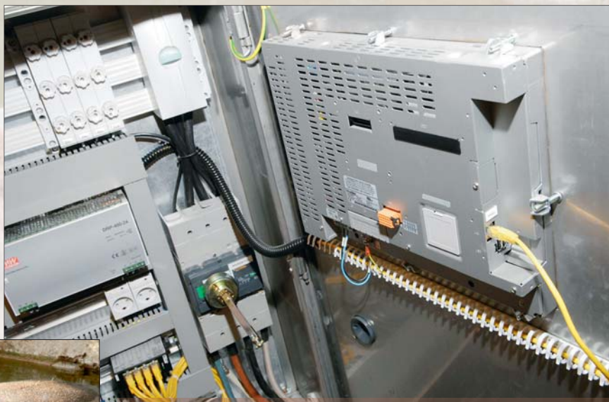
Begge hovedtavler betjenes fra et Pro-face HMI panel på forpladen/lågen. På fotoet ses bagsiden af skærmen og den centrale Ethernet forbindelse.
