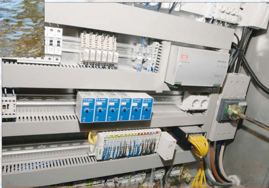
Tavlerne er opbygget traditionelt, men der er ikke sparet på komponenterne. Wagos I/O moduler ses midt i fotoet. Et modul måler kun 12 mm i bredden.
